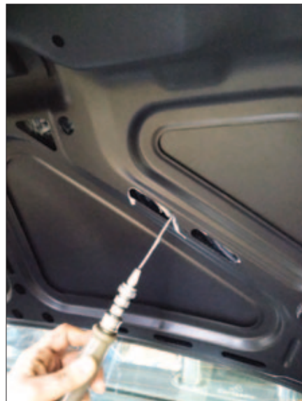
Na het drogen kan de uiteindelijke behandeling beginnen. De holle ruimtes worden eerst gevuld met Dinitrol ML
